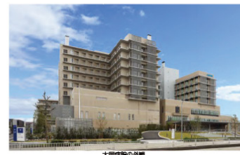
大同病院の外観
